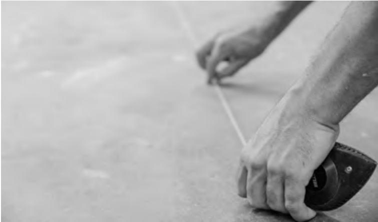
Set the guideline | Plantea la línea maestra | Établir la ligne maestrale | Spannen Sie die Richtschnur
